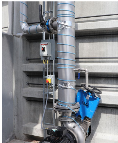
In de Gemidan Ecogi fabrieken worden AVK vlinderkleppen en plaatafsluiters gebruikt.
