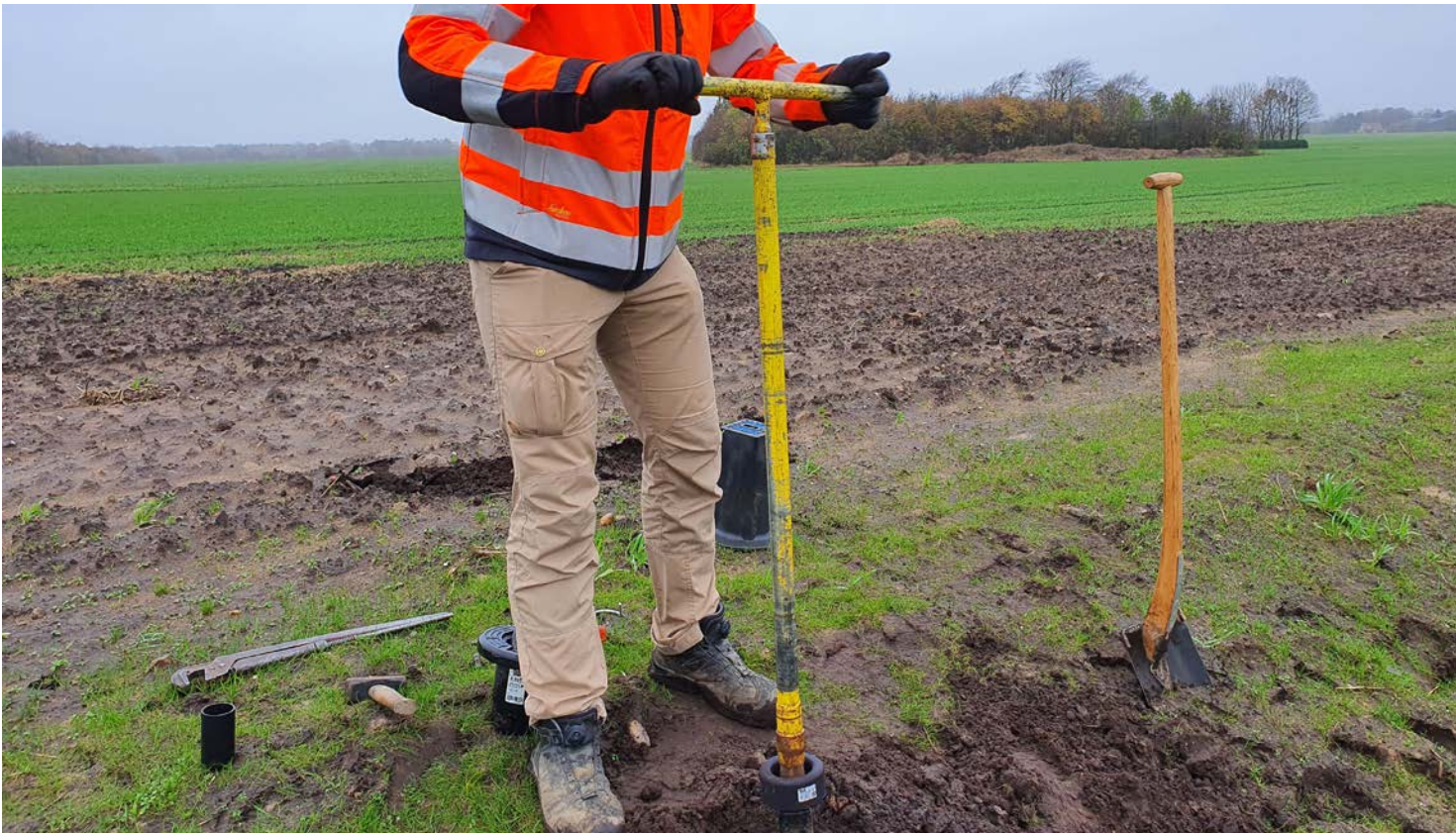
The VID I Positioner is gekalibreerd en klaar om de schuifpositie van de schuifafsluiter te detecteren.
