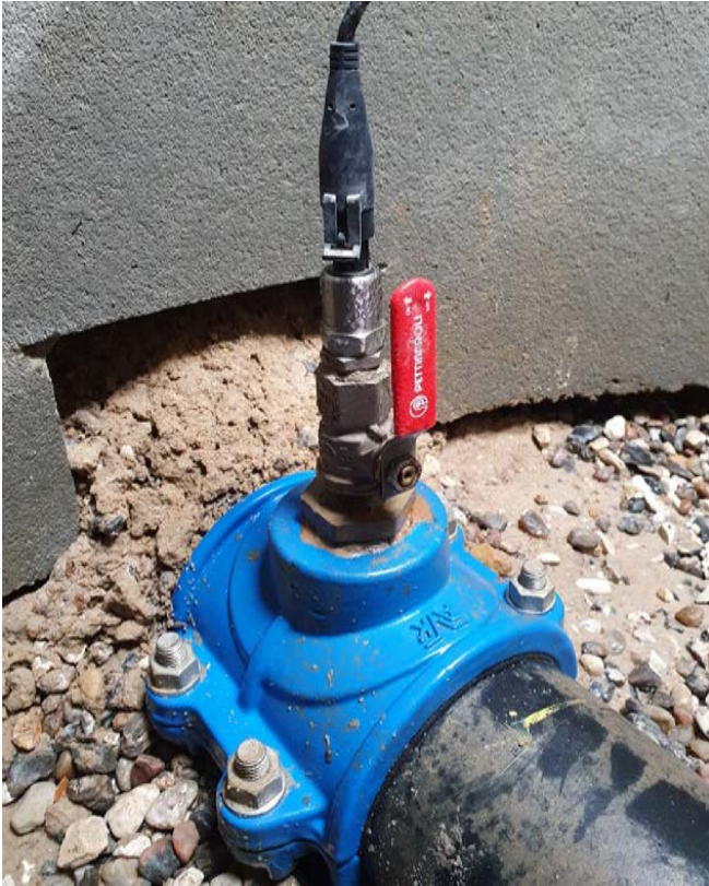
Door het draadloze karakter van IoT kunnen de druksensoren op elk cruciaal punt in het distributienetwerk worden geïnstalleerd.
