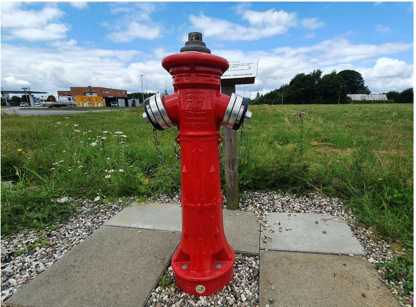
Brandkraan met VIDI Caps. Het gebruik van een brandkraan is van grote invloed op de druk in een gebied. Daarom is het belangrijk dat het waterbedrijf weet wanneer een brandkraan wordt gebruikt, om zo onderscheid te kunnen maken tussen drukval als gevolg van gebruik of een lekkage.
